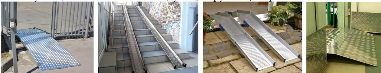
**Проблемы.** Низкая твердость и износостойкость, не очень высокая коррозионная стойкость обуславливают быструю потерю внешнего вида. Низкий коэффициент трения алюминия и резины приводит к повышению вероятности проскальзывания, осложняет условия подъема и спуска, увеличивает риск получения травм. В зимний период остро проявляется обледенение.
